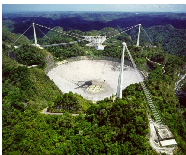
รูปที่ 2 กล้องโทรทรรศน์วิทยุอะเรซิโบ (Arecibo Telescope) เส้นผ่านศูนย์กลางจาน Parabolic 300 เมตร
